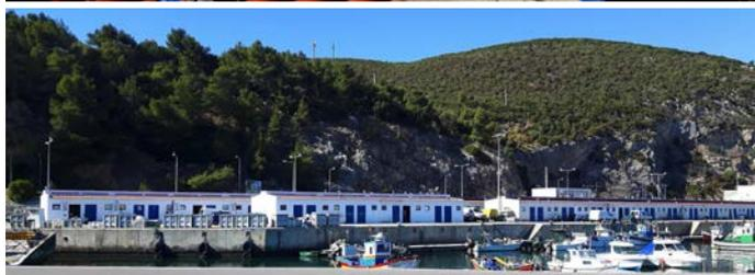
**A** Docapesca concluiu a reabilitação das fachadas e coberturas dos armazéns de aprestos (Blocos 1 e 2) do Porto de Pesca de Sesimbra, no montante de 25.000 euros. Nas fachadas, as intervenções incidiram na limpeza, recuperação, proteção e pintura dos paramentos existentes. Nas coberturas foi feita uma impermeabilização e ventilação dos armazéns.
